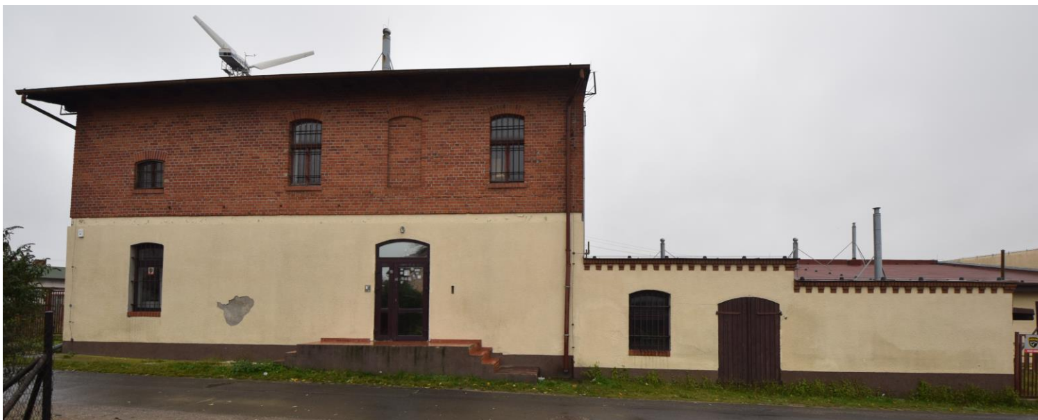
Widok od północnego zachodu
