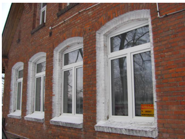
Rys. 82. Wymieniona stolarka okienna w budynku Świetlicy Wiejskiej w Czemlewie
