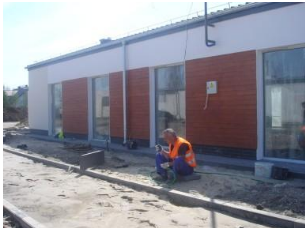
Rys. 80. Remont Świetlicy Wiejskiej w Otowicach
