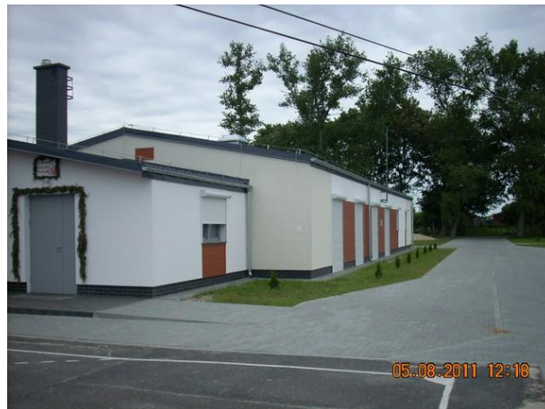
Rys. 81. Świetlica Wiejska w Boluminie po remoncie
