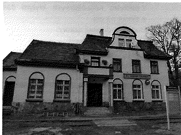
Fot. 10. Budynek dworca PKP Źródło: zdjęcie własne
